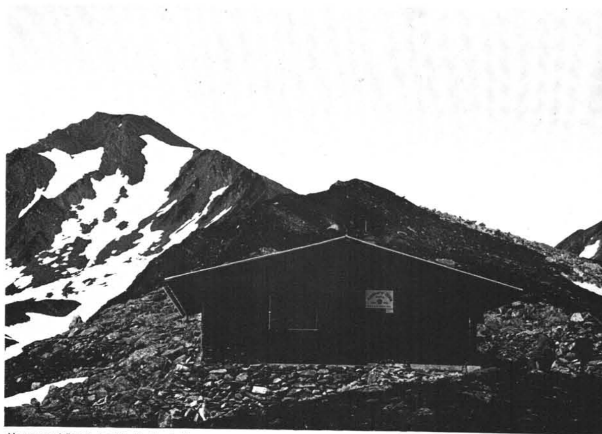
„Hexenseehütte“. Architekt: Armin Herrmann
