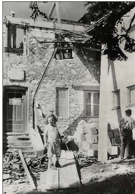
Zweiter Bauabschnitt 1970 – Aufstockung des Hauses.
