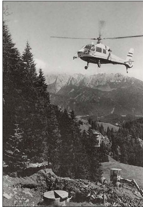
Hubschrauber bei der Erweiterung der Wasserversorgung 1985
