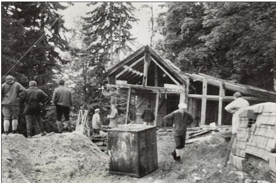
Abbruch des Pferdestalles
