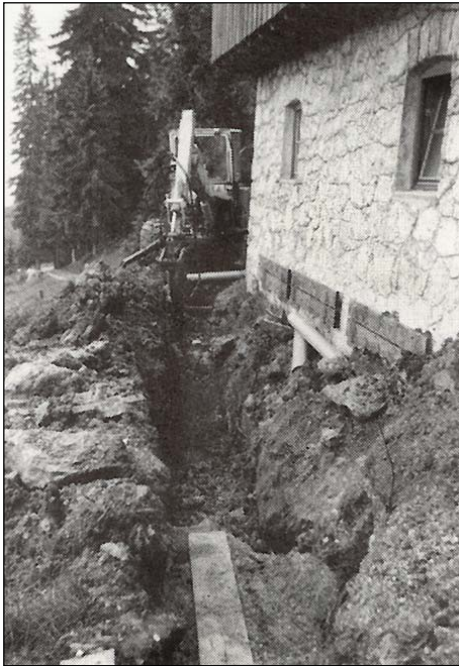
Bau der Kläranlage 1985
