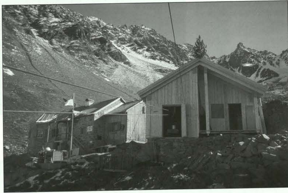
Neue Seilbahnstation mit Winterraum 2001
