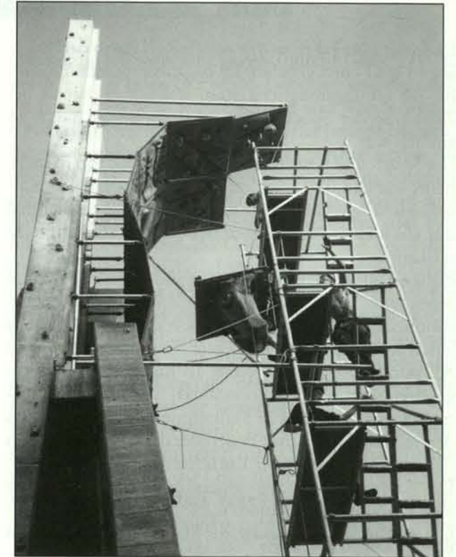
Endgültige Fertigstellung des Kletterturmes
