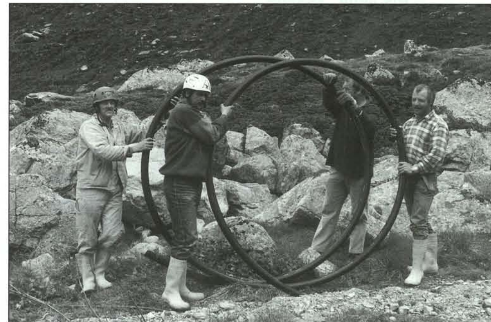
Einbringen der flexiblen Wasserleitung in den Graben
