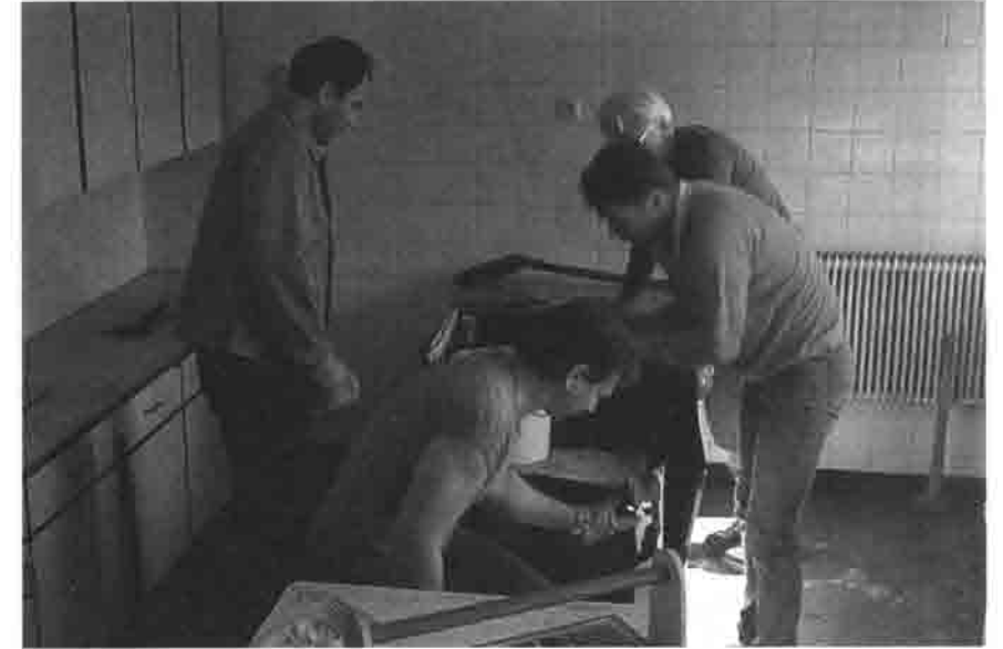
Die Schlacht ist geschlagen – Sanierung des Schwabenhauses 1987.
