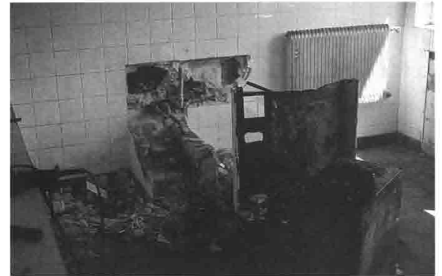
Küchendemontage bei der Sanierung des Schwabenhauses 1987.
