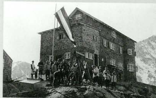
Einweihung des Materialaufzuges 1968
