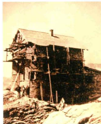
Baustelle Siegerlandhütte um 1928
