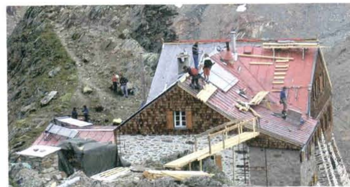
Dacharbeiten an der Hildesheimer Hütte
