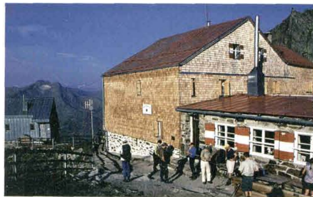
Hildesheimer Hütte mit dem Winterraum (Nebengebäude hinten links)
