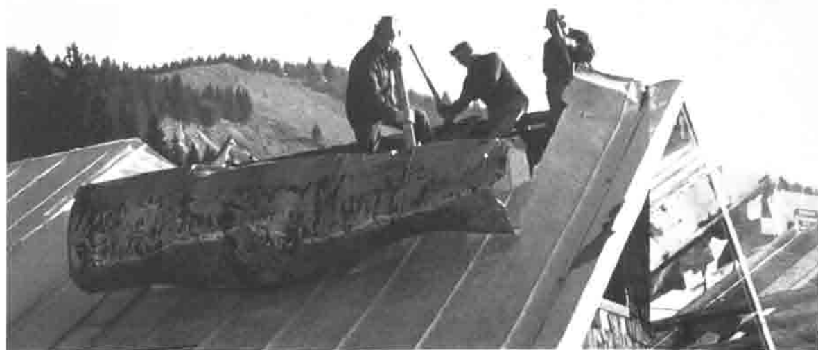
Die drei Hüttenwarte Messner, Haslinger und Auzinger ziehen der alten Braunauer Hütte die „Haut“ ab.
