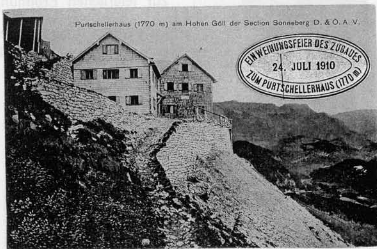
Das Purtschellerhaus nach dem Anbau im Juli 1910
