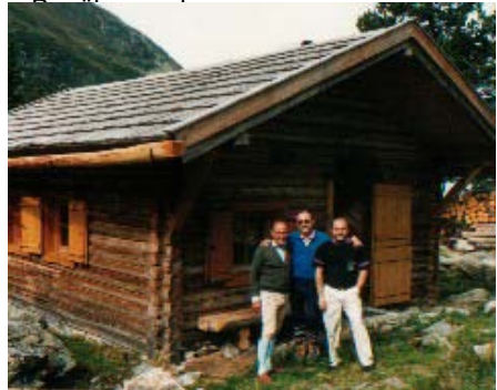
Der neue Winterraum
