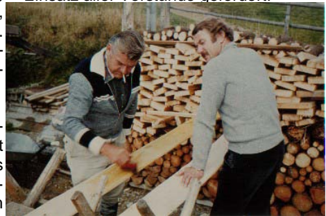
Arbeiten für die Holzdecke
