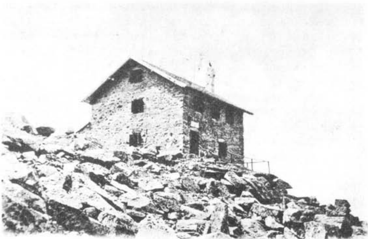
Gruss von der Landshuter Hütte. (2740 m)
