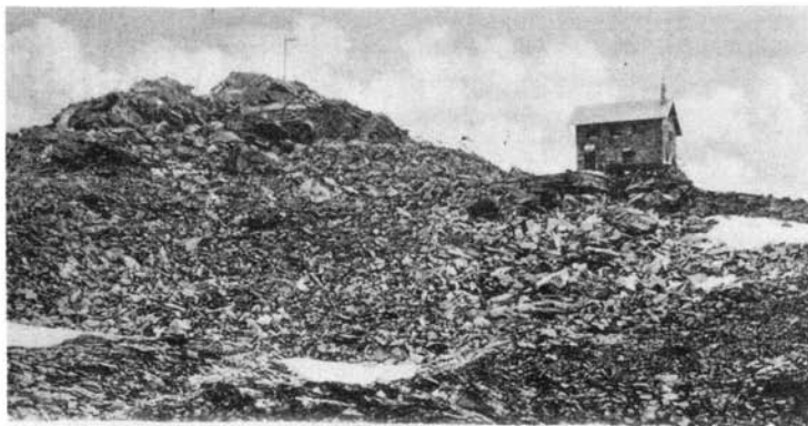
Gruss von der Landshuter Hütte (2740 m.)
