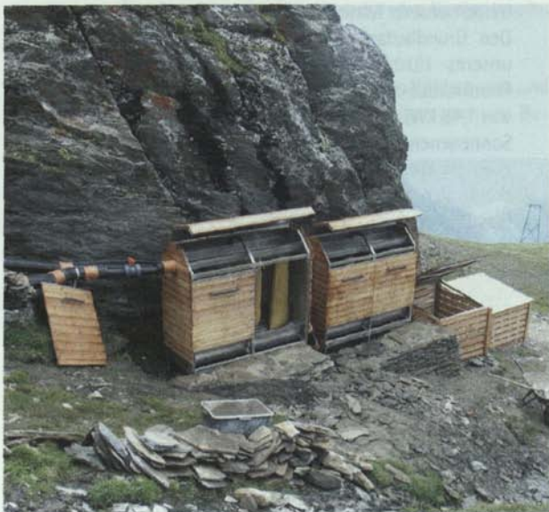
Filtersackanlage und Rotteboxen
