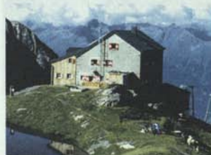
Blick von Nordost
