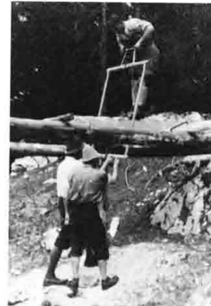
Toni Schlenz mit dem Handgatter beim Bau des Mulistalls.
