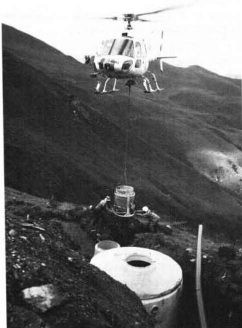
Viele Hubschrauberflüge waren erforderlich, um das Material zur Baustelle zu transportieren.
