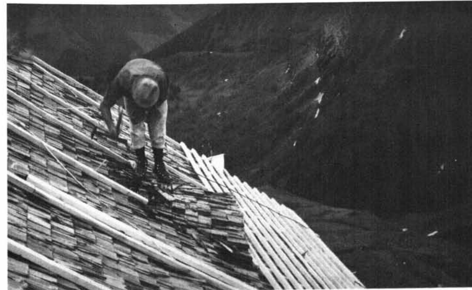
Als eine der ersten Aufgaben mußte das Hüttdach erneuert werden. Foto: Georg Sinzinger.
