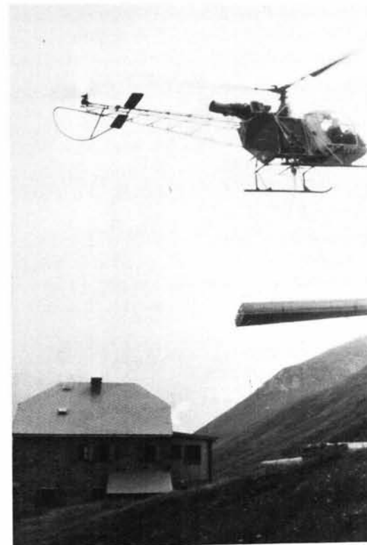
Am 4. Juli 1971 erfolgte erstmals ein Materialtransport zur Gleiwitzer Hütte per Hubschrauber. Insgesamt acht Tonnen Baumaterial wurden in acht Flügen in 90 Minuten zur 2176 m hoch gelegenen Hütte transportiert.
