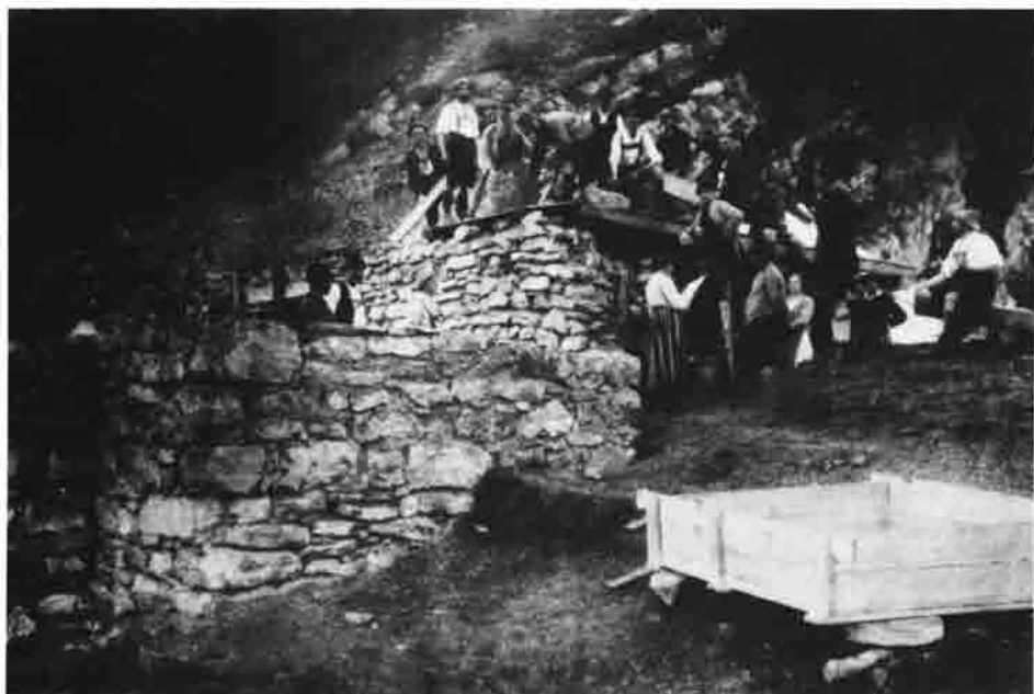
Trotz schlechter Witterung – die Nebelschwaden sind auf diesem Foto gut zu sehen – nahmen die Arbeiten am Scharfreiter 1923 ihren Fortgang. Gut zu erkennen sind u.a. folgende Hauptakteure (v.l.n.r.): Bock (mit Bart), Käuferle (Weste) und Zech (Arm in die Seite gestemmt).
