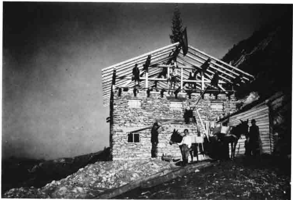
Im September 1923 wurde der Dachstuhl aufgestellt. Das Baumaterial mußte teils mit eigener Muskelkraft, teils mit Tragtieren aus dem Tal heraufgeschleppt werden.
