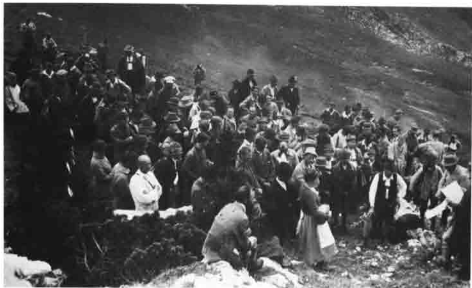
Grundsteinlegung Tölzer Hütte 29.6.1922
