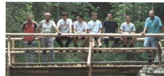
Auch beim Wegebau profitiert die Sektion von der Kooperation mit Berufsschülern. Hier haben Jung und Alt gemeinsam eine Brücke im Stuhlbachgraben neu errichtet.
