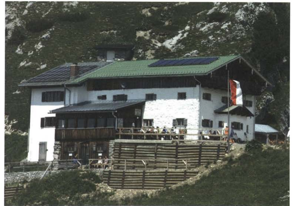
So präsentiert sich unsere „Tölzer Hütte“ heute dem Besucher; gut zu erkennen sind die sehr aufwändigen Maßnahmen zur Hangsanierung.
