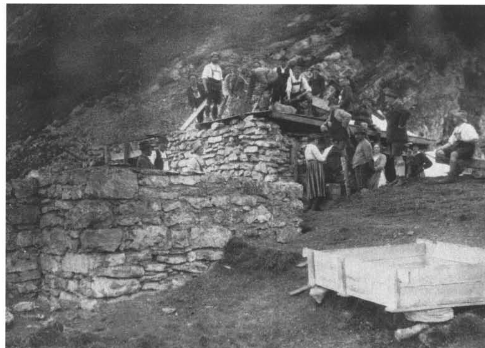
Viele Hände halfen beim Bau der „Tölzer Hütte“.
