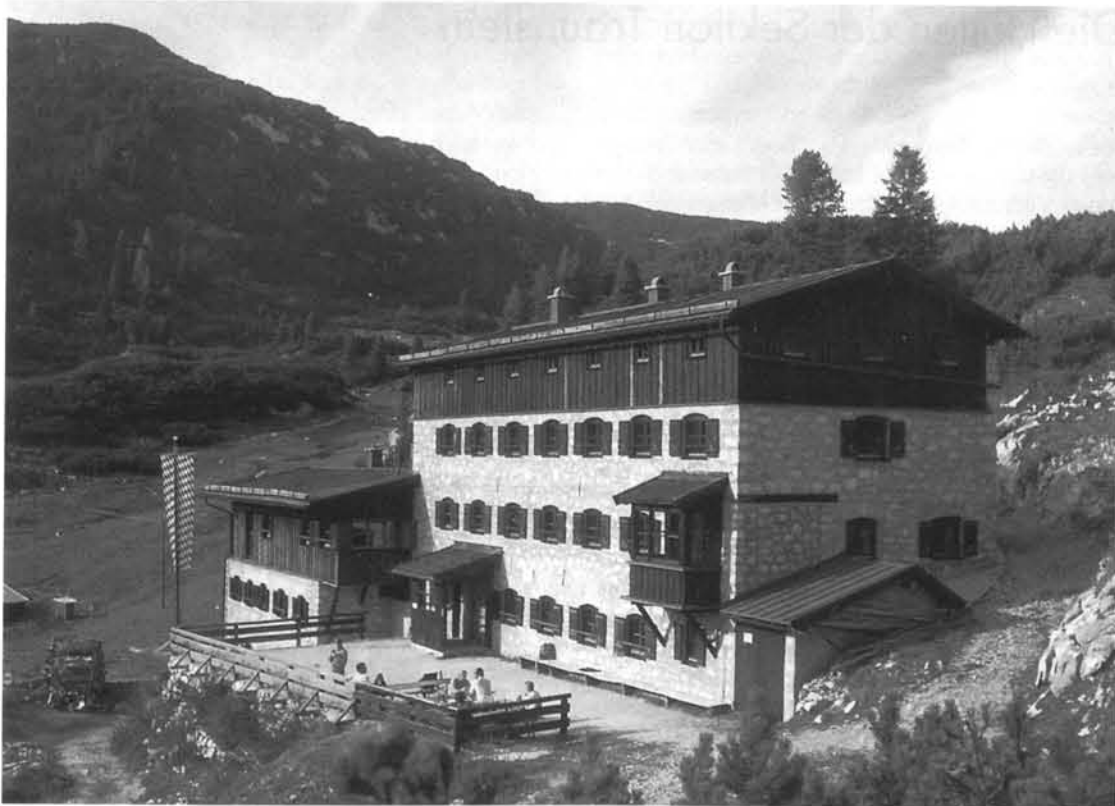
Karl-Merkenschlager-Haus auf der Reiter Alm nach dem Neubau. (Foto: Archiv Sektion)
