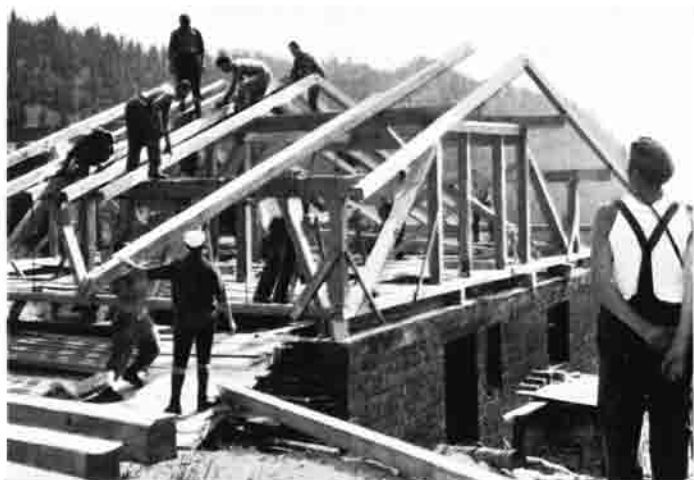
Aufbau des Dachstuhls
