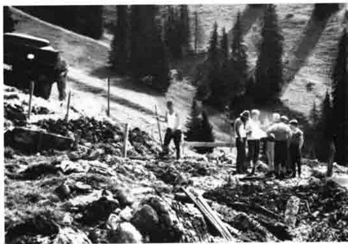
Erdaushub am Standpunkt der neuen Hütte
