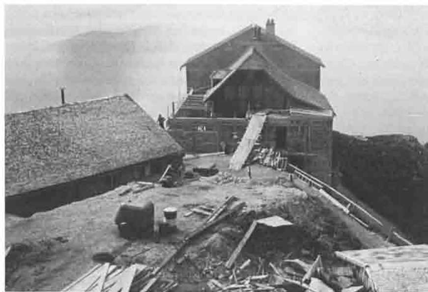
Erweiterungsbau Gruttenhütte, 1962/1963, von Norden
