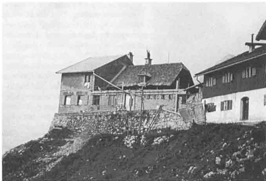
Erweiterungsbau Gruttenhütte, 1962/1963, von Osten
