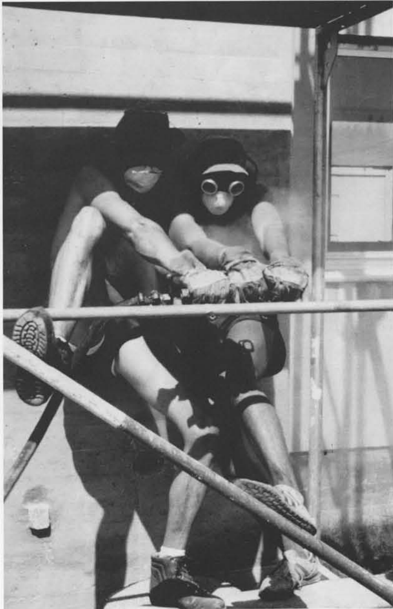
Wir bauen unseren Kletterturm 1988. Christian Enzinger und Hans Moser beim „Kompressorn“
