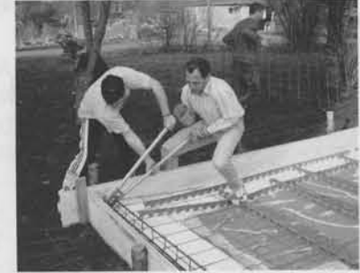
Erweiterung unserer Kletteranlage – Bild oben: Bewehrung der Betonplatten, Bild links: Montage der Betonplatten mit Hilfe eines mobilen Autokrans
