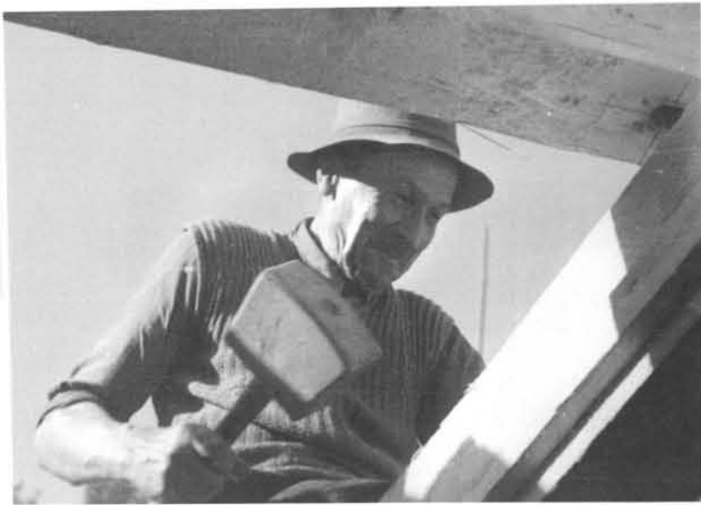
Der Zimmerer Karl Weiger beim Bau der Uli-Wieland-Hütte, 1949.
