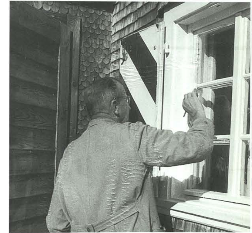
Karl Weiger beim Streichen der Fenster.
