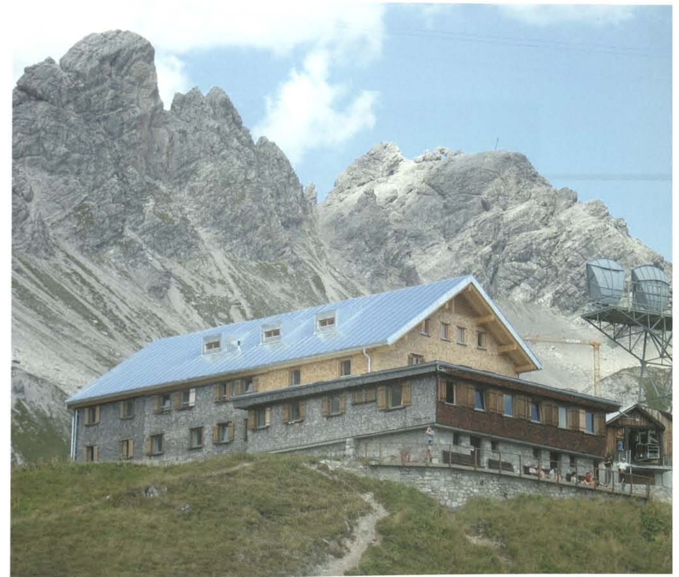
Die Ulmer Hütte nach dem Umbau 2003.
