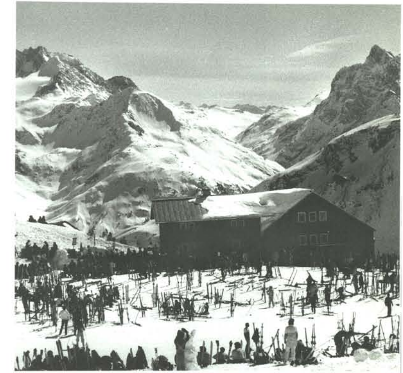
↑ Ulmer Hütte, 1975. ← Die Veranda mit einzigartigem Bergblick, 1960.
