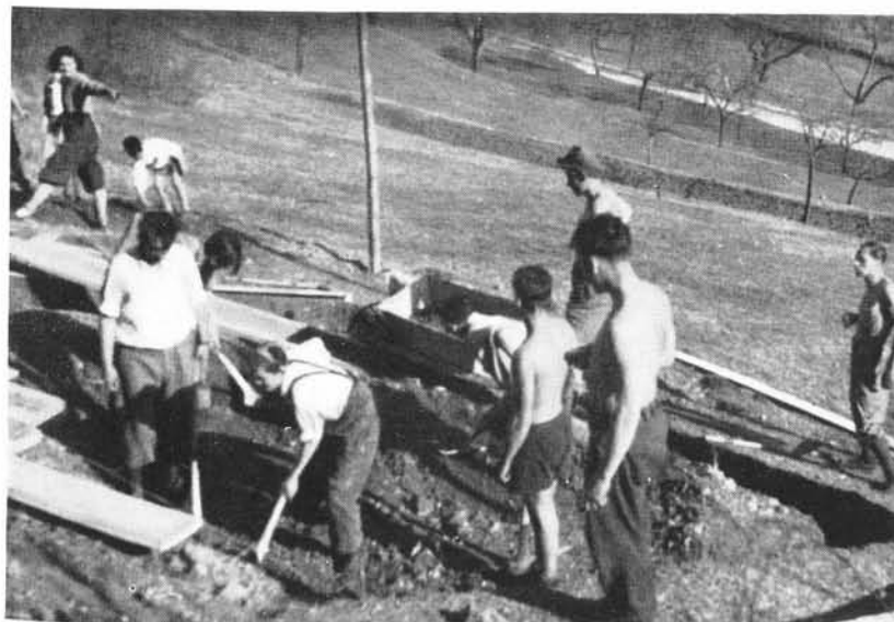
Uli Wieland-Hütte Ausheben des Baugrunds
