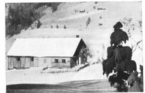
Die Schwand-Alpe vor dem Umbau
