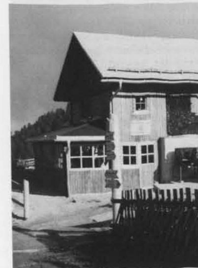
Anbau Weidener Hütte
