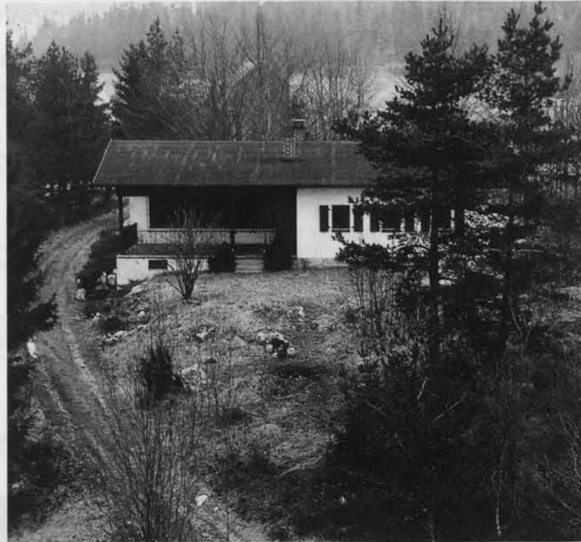
Die Steinwaldhütte nach der Fertigstellung
