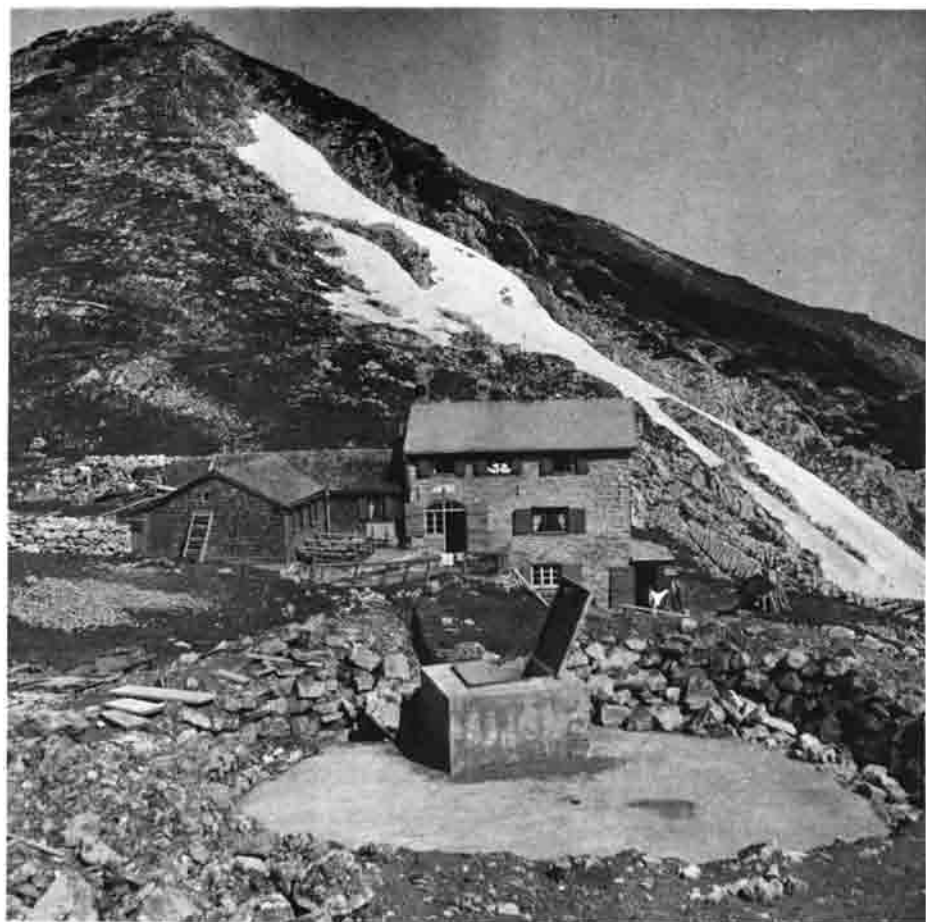
Vor dem Erweiterungsbau 1938
