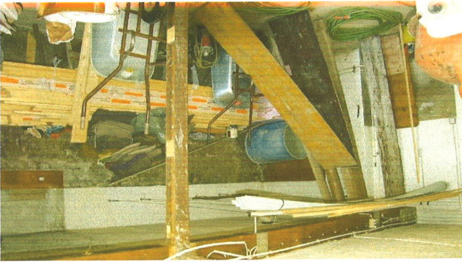
Sanierung der Außenmauer an der Ostseite der Hütte, Erneuerung des Hüttenanbaus (Werkstatt und Lager) an der Ostseite der Hütte, Ausbau des ehemaligen Winter-raums zu einem Trockenraum durch Fa. Forst-und Alpinbau Mangold, Eschenlohe.
