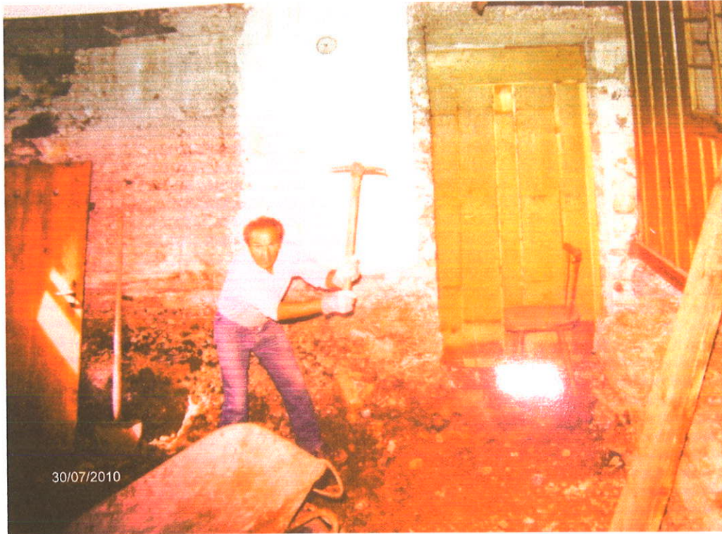
Ausgrabungsarbeiten im entkernten Farchanter Anbau
