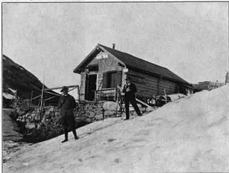
Krottenkopfhütte im Jahre 1884
