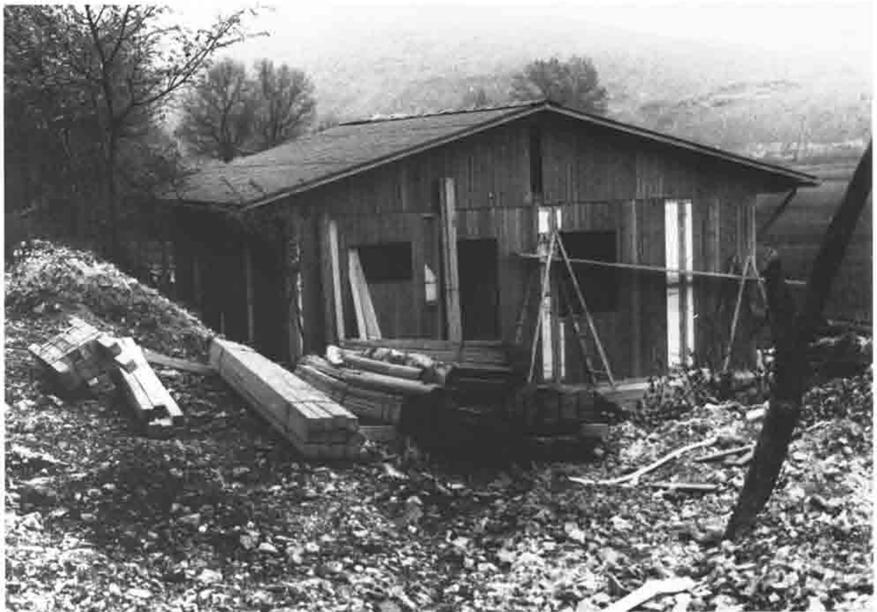
Abbildung 23 Aufgestelltes Fertigholzhaus im Hochtal von San Gregorio Magno
