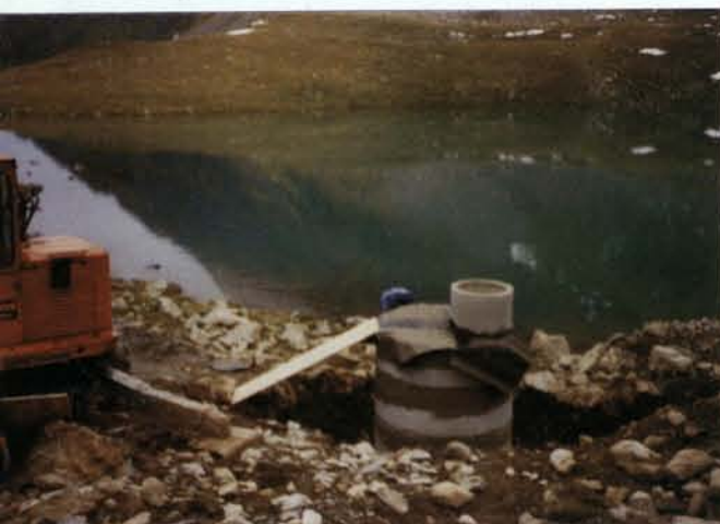
Bauarbeiten am Herzsee: Hier wird das Trinkwasser für die Hütte gewonnen
