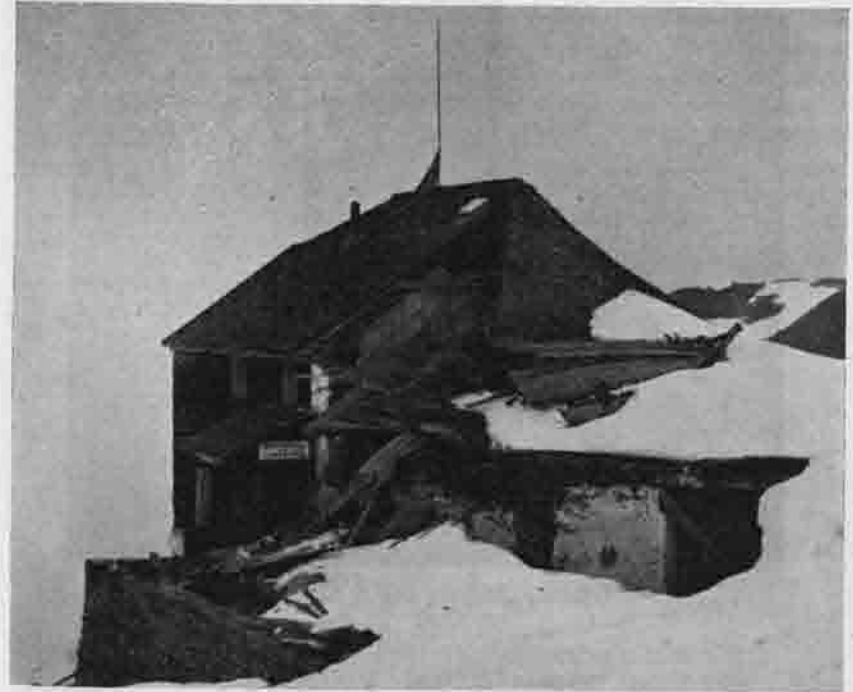
Edelhütte 1951 durch eine Lawine beschädigt
