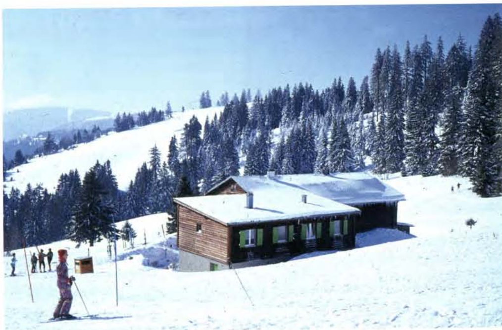
Die Vogesenhütte mit dem Mitte der 60er Jahre errichteten Anbau.
