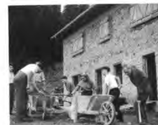
Eigenleistung beim Neubau
