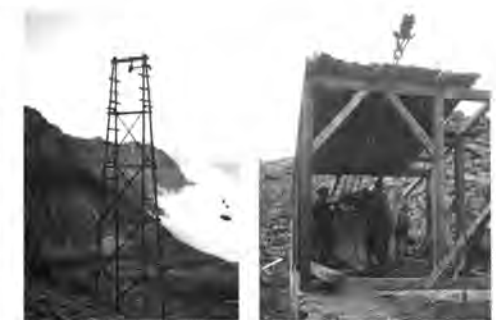
... und Stück für Stück mit einer eigens gebauten provisorischen Seilbahn auf den Berg transportiert
