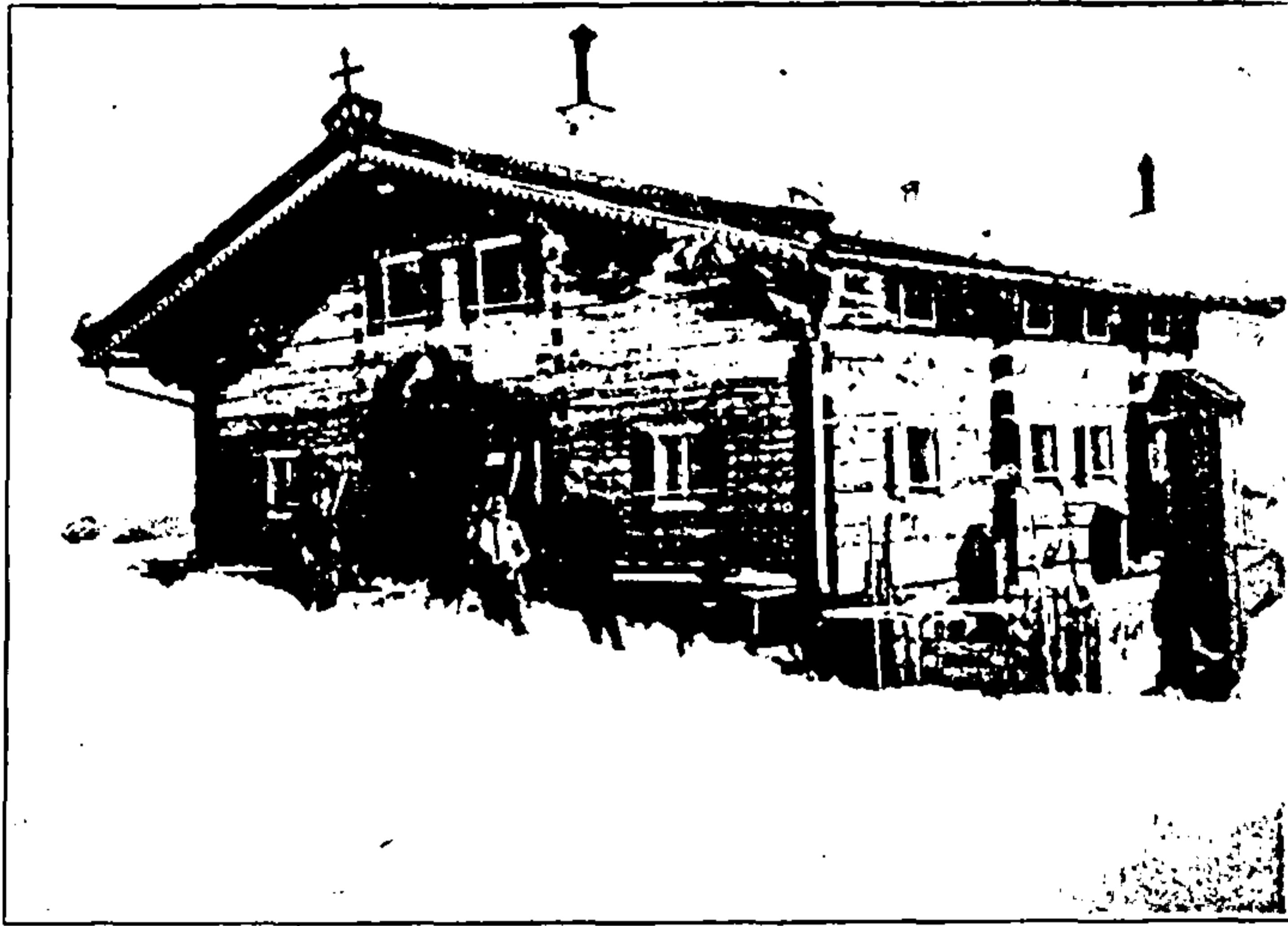
Robingerhütte am Harlosanger, Winterhütte der Sektion A. E. C.
