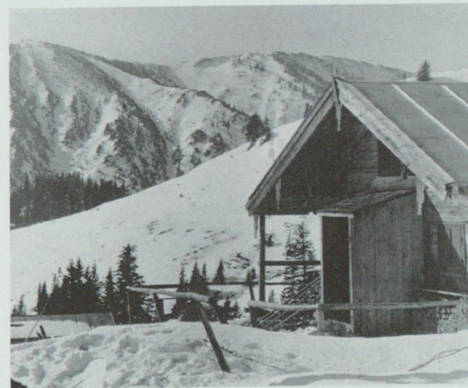
Neuhüttenalm mit Windfang für den Winter (Foto H. Adolf)
