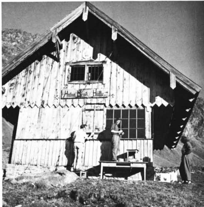
Die Verandafenster werden eingesetzt
