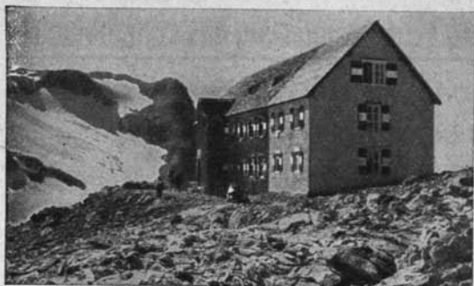
Straßburger Hütte des D. u. Oe. A. V., 2700 m. — Die Außen- und Zwischenwände des 1930 ausgeführten Anbaues wurden in Heraklith erstellt, außerdem wurde das Dachgeschoß mit Heraklith ausgebaut
