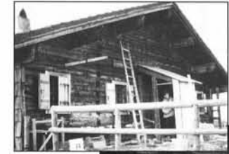
Erneuerung des Wind- fanges.
