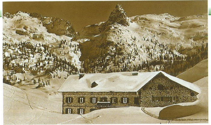
Das Schlafhaus ist nun durch einen Anbau mit der alten Funtenseehütte verbunden. (Foto: Sektionsarchiv)
