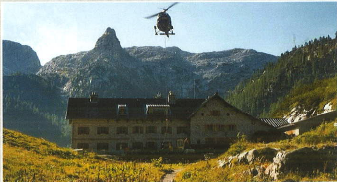
Ab 1974 konnte das Funtenseehaus durch einen Spezialtraktor (siehe Chronik) angefahren werden. Gelegentlich wurde die Hütte bereits von Hubschraubern der Bundeswehr beliefert. Anfang der 90er Jahre wurde die Hüttenver- bzw. -entsorgung ausschließlich von Hubschraubern übernommen.
