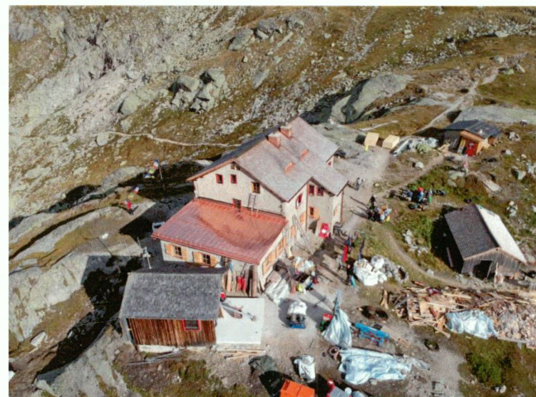
Bouwterrein rond de hut, foto 2019
