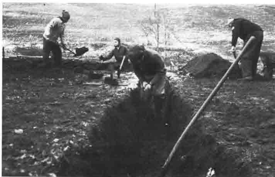
Der Fundamentgraben wird gemacht.
