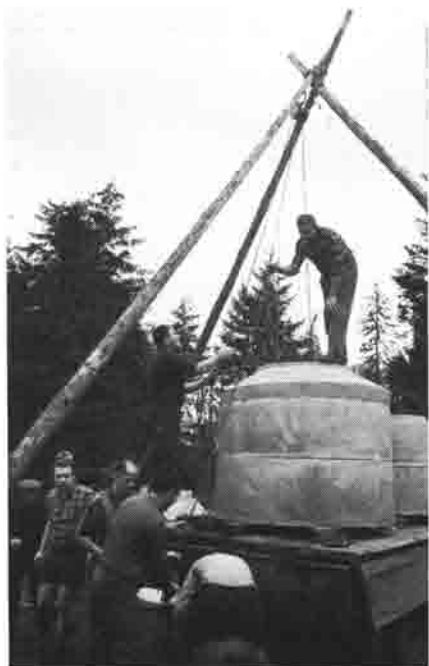
Die Klärgrube wird abgeladen.
