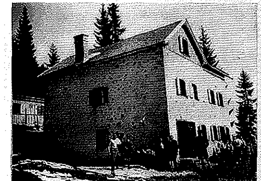
Nach der Zerstörung der alten Gaudeamushütte im Februar 1924 durch eine Lawine wurde an anderer Stelle ein Neubau errichtet.
