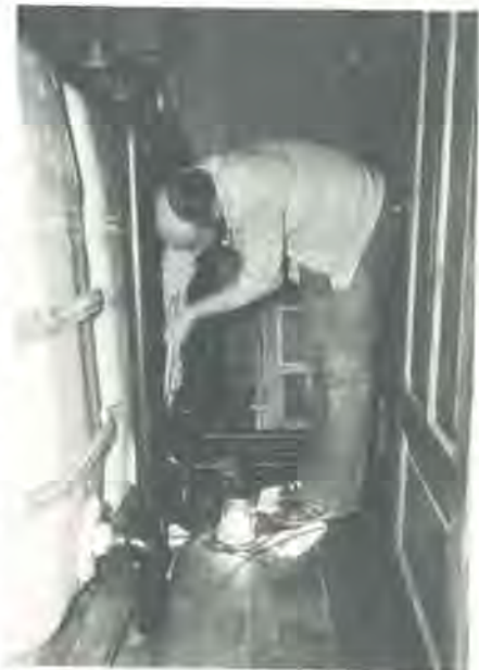
Auswechseln von undichten Ventilen an Wassertanks vom Brandenburger Haus
