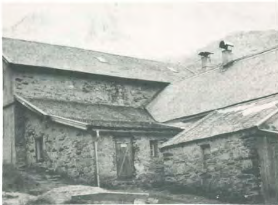
Furtschaglhaus – Die abgebrochenen Anbauten Ansichten von Nordwesten
