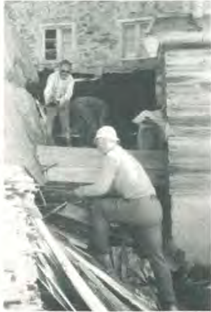
Arbeitseinsatz 1988: Die alten Holzschindeln werden entnagelt und gestapelt. Detlef Zschiedrich, dahinter ein fränkischer und holländischer Helfer. Foto: K. Kundt
