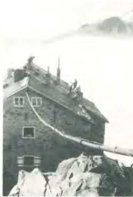
Arbeitseinsatz 1988: Die alten Holzschindeln werden entnagelt und gestapelt. Detlef Zschiedrich, dahinter ein fränkischer und holländischer Helfer. Foto: K. Kundt
