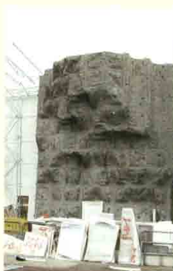
Aufbau der neuen Wand
