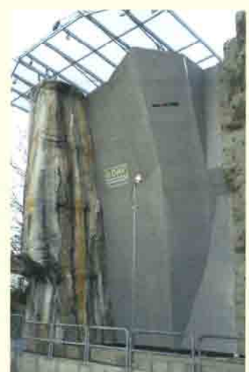
Fertigstellung der neuen Kletterwand
