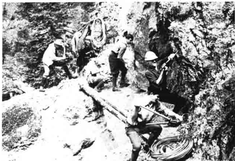
Arbeitseinsatz im Birkental beim Wegebau
