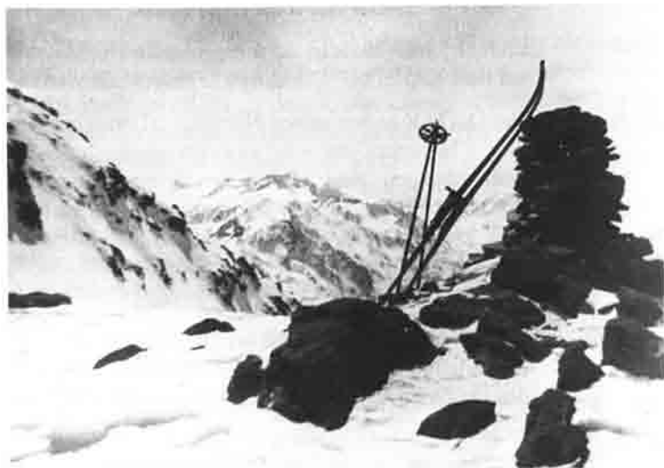
Ostern 1931- Am Bauplatz der Hochstubaishütte
