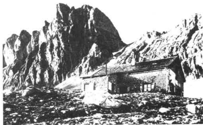
Die Hütte 1921 in dem Bauzustand, wie sie 3 Jahre später von der Sektion Düsseldorf übernommen wurde.
