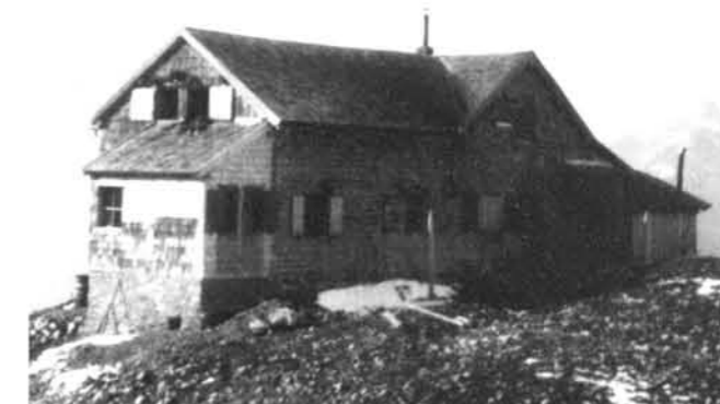
1926, zwei Jahre nach der Düsseldorfer Übernahme, hat die Hütte bereits einen Wasch- und Toilettenanbau.
