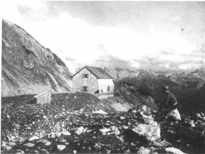
Die Hütte hat ihren Betrieb aufgenommen. Das Toilettenhäuschen im Vordergrund tat seinen Dienst bis 1925
