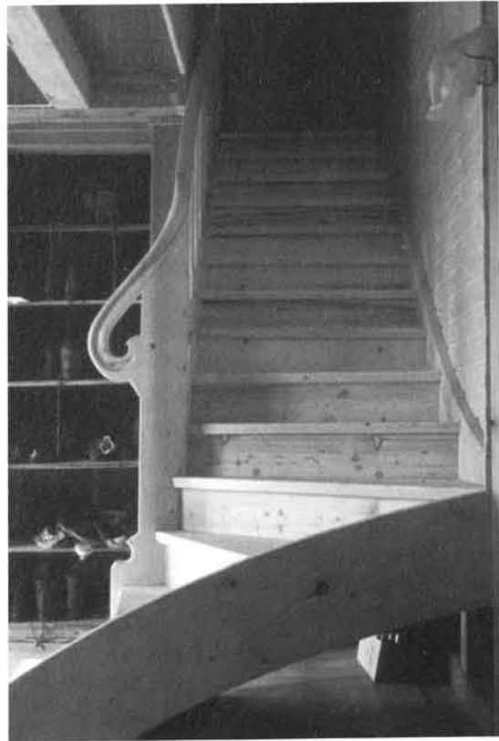
Ein Glanzstück Tiroler Handwerkskunst: Die neue Treppe, 1976 geschaffen vom Tischler und Hüttenwirt Erwin Vonier.
