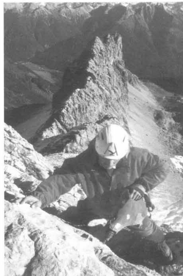
Der Kletterhelm wird zum Bauhelm: Sanierungsexperte Toni Freudig mit dem 8 Kilo schweren Akkubohrer
