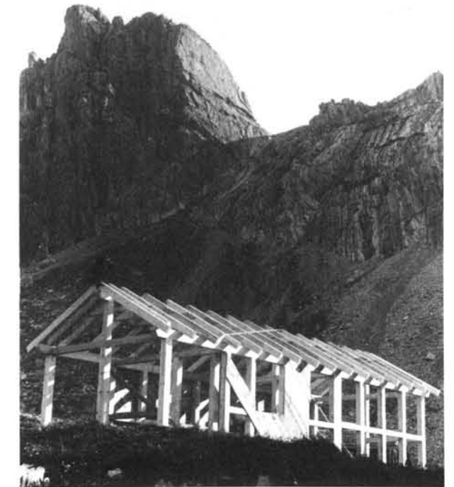
1989 Baubeginn des Winterraumes
