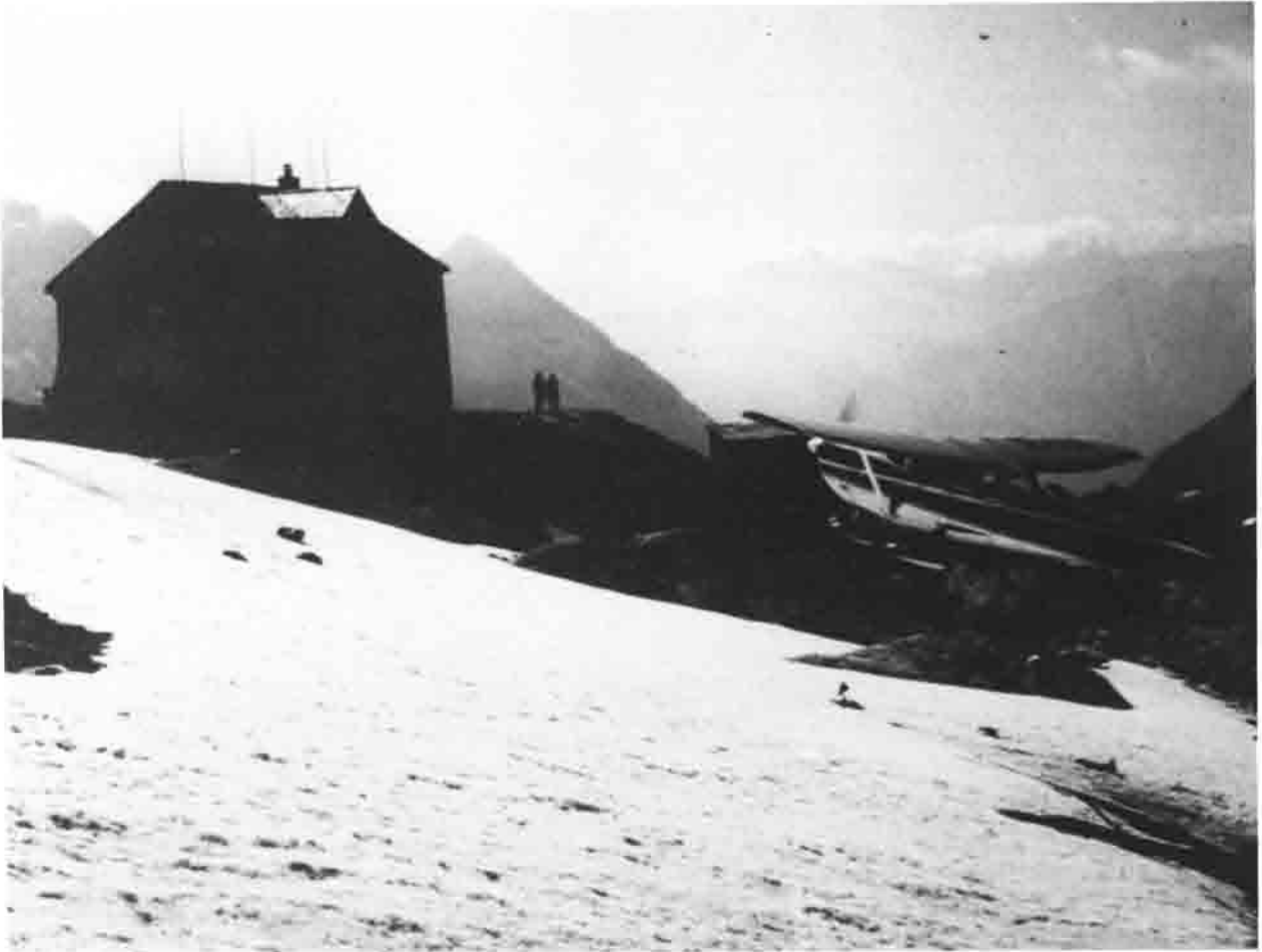
Versorgung mit Kohle – aus der Luft.
